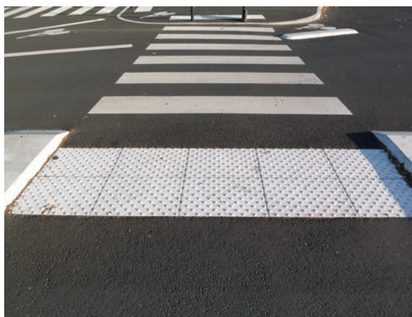
Dalle podotactile en béton moulé Alkern pour signaler le début du passage piéton.
